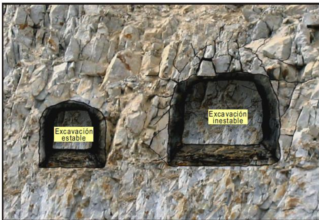
Figura 63. Tamaño de la excavación
