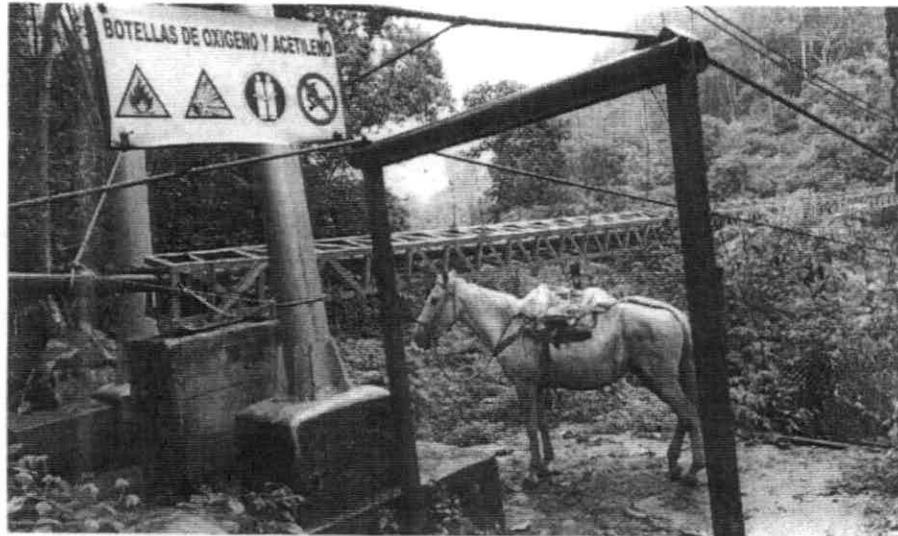
Foto 1. Se evidencia desplazamiento desnivel del puente que contiene el ducto del gas y los tornillos sueltos.
