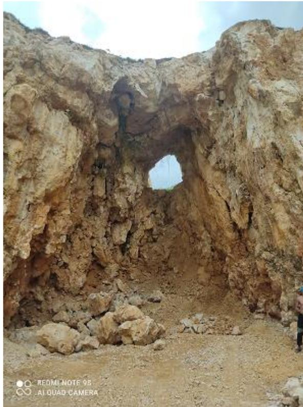
Punto 10. Cárcava realizada a profundidad. Se evidenció alto riesgo de caída de materiales. Se encontró personal en labores mineras.
