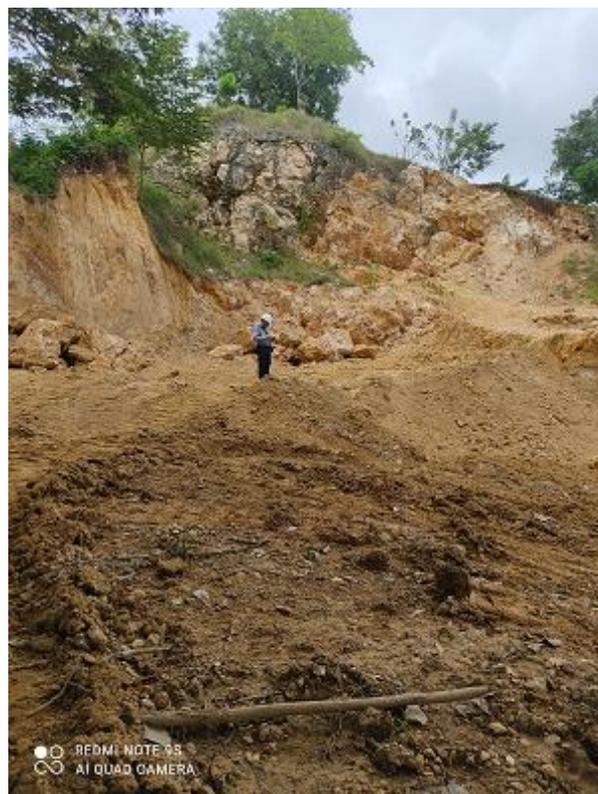
Punto 6. Frente de explotación activo. Remoción de material del suelo y de los taludes, huella de volqueta hasta el punto de extracción.
