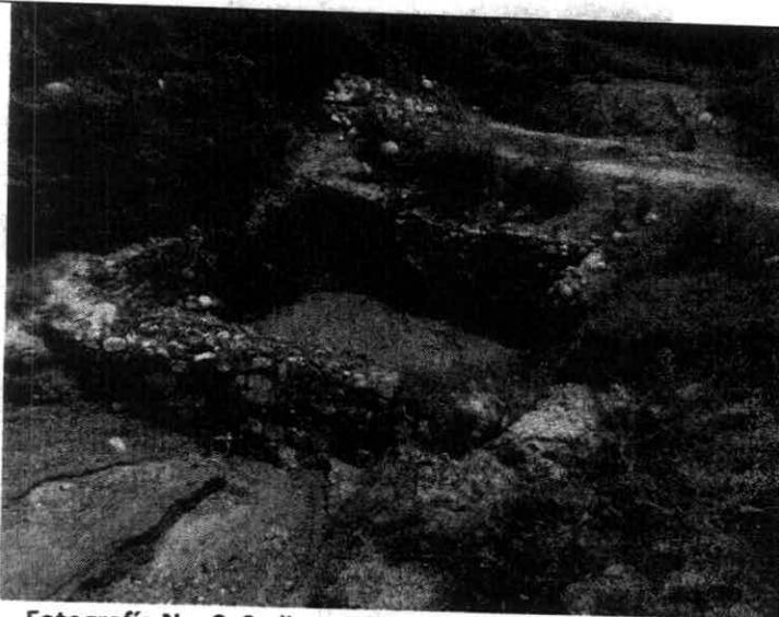
**Fotografía No. 9.** Sedimentadores ubicados sobre el drenaje, observase colmatadas sin mantenimiento, área intervenida sin licencia ambiental
