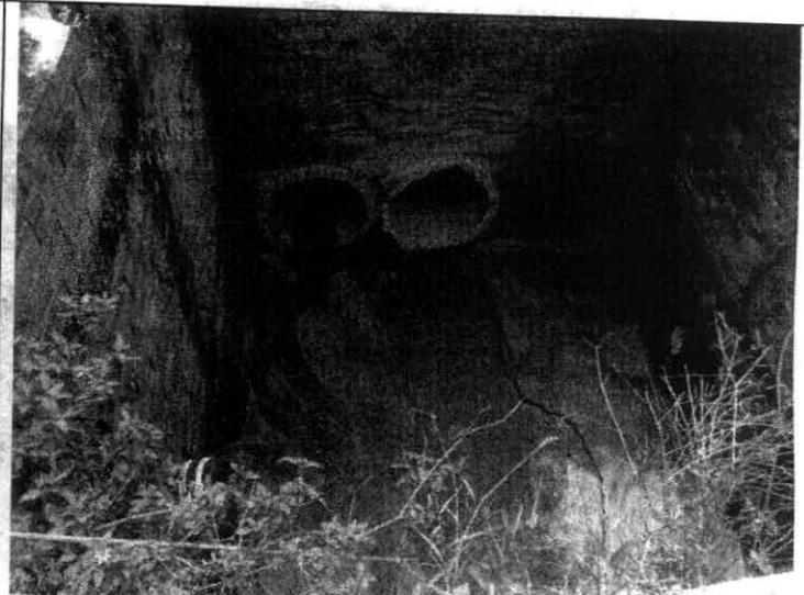
**Fotografía No. 10.** Sedimentadores ubicados sobre el drenaje, observase colmatadas sin mantenimiento, área intervenida sin licencia ambiental
