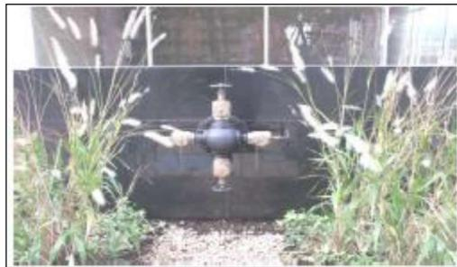
Cabezal de pruebas sistema
