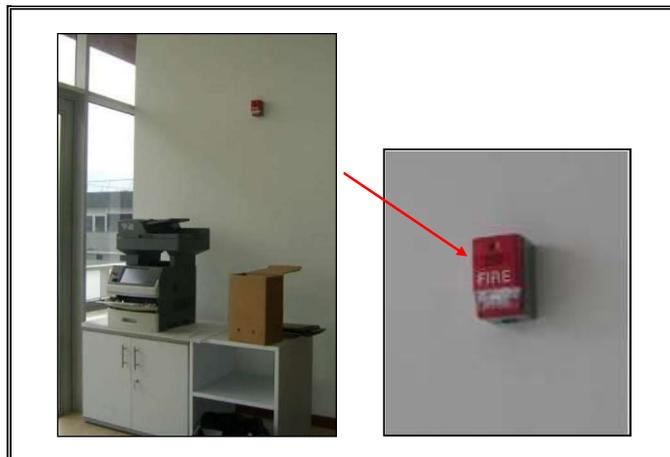
Cuenta con sistema de comunicación y detección de alarma general para casos de emergencia con sirenas, luz estroboscópica, estaciones de alarma, con mensaje pregrabado.
