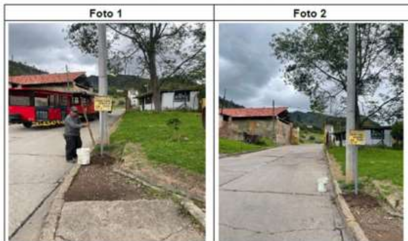
Registro Fotográfico De Instalación
