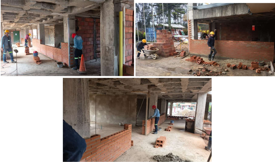
Ilustración 37 - Avance físico del 81 % de obra
